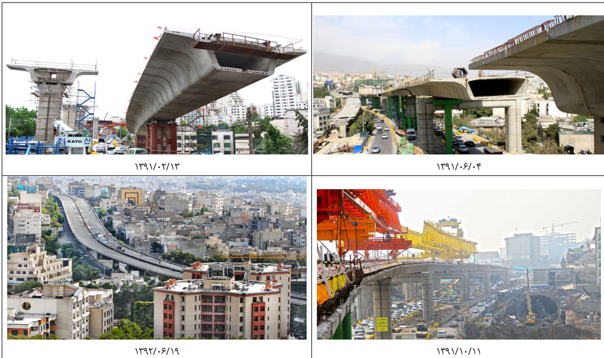
شکل ۳. تصاویر ساخت بزرگراه طبقاتی صدر
