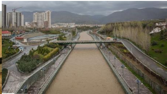
شکل ۱. نمونه‌هایی از تغییرات در بستر رودخانه کن (کانالیزه کردن و بتنی کردن بستر، تغییر حالت طبیعی حاشیه‌ها و حریم رودخانه، پله‌بندی بستر، برداشت شن و ماسه و ایجاد شن‌چاله‌ها در مسیر کریدور رودخانه‌ای کن در تهران
