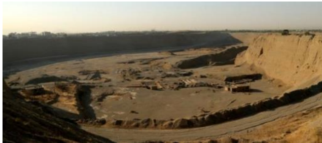
شکل ۱. نمونه‌هایی از تغییرات در بستر رودخانه کن (کانالیزه کردن و بتنی کردن بستر، تغییر حالت طبیعی حاشیه‌ها و حریم رودخانه، پله‌بندی بستر، برداشت شن و ماسه و ایجاد شن‌چاله‌ها در مسیر کریدور رودخانه‌ای کن در تهران
